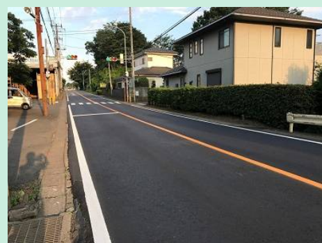
県道の修繕（粕谷）
