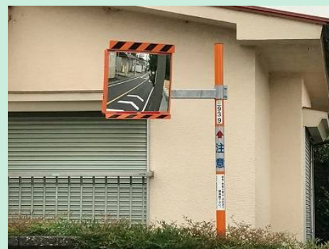
カーブミラーの設置（三ヶ島5丁目）
