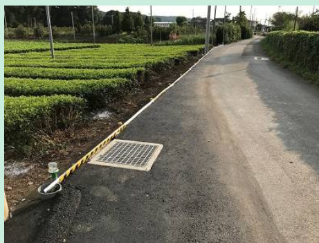
市道の修繕・浸透料の設置（粕谷）
