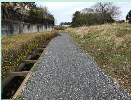
市道の修繕（三ヶ島1丁目）
