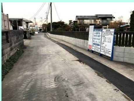
配水管の布設（林1丁目）
