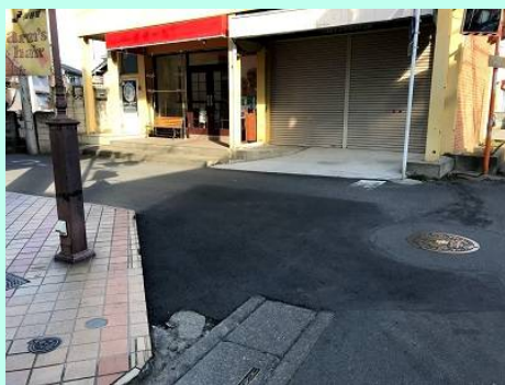
市道の修繕（狭山ヶ丘1丁目）
