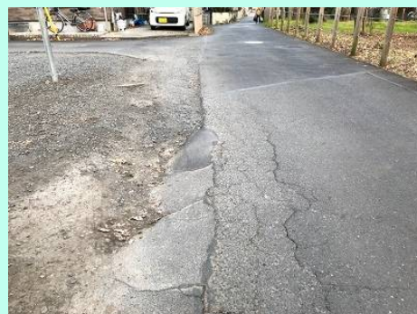
市道の修繕（若狭4丁目）
