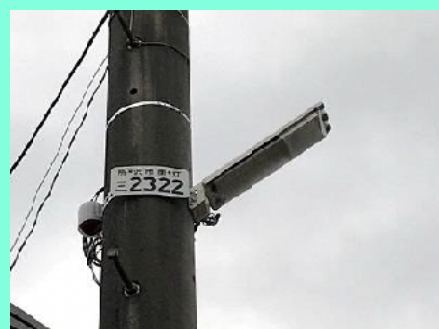
道路照明灯の設置（三ヶ島2丁目）
