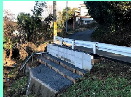
市道の緊急修繕（三ヶ島1丁目）
