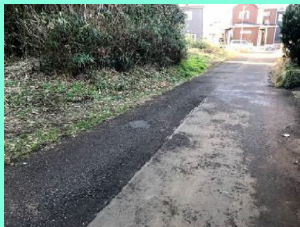
市道の修繕（堀之内）
