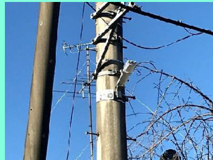
道路照明灯の設置（三ヶ島1丁目）
