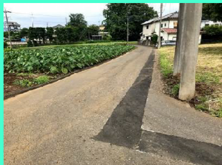
水道管の更新（糞谷）
