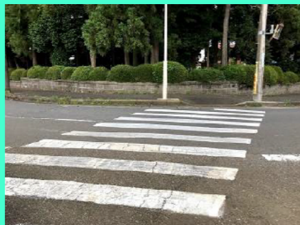
横断歩道の再塗装（堀之内）
