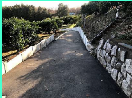
市道の改修（三ヶ島1丁目）
