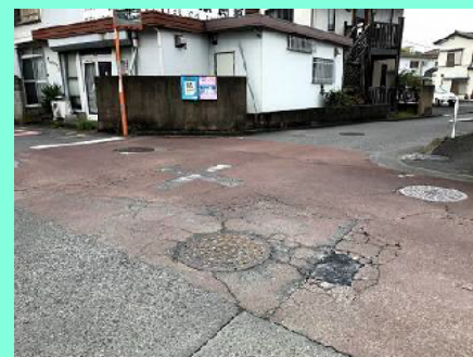
市道の修繕（和ヶ原1丁目）
