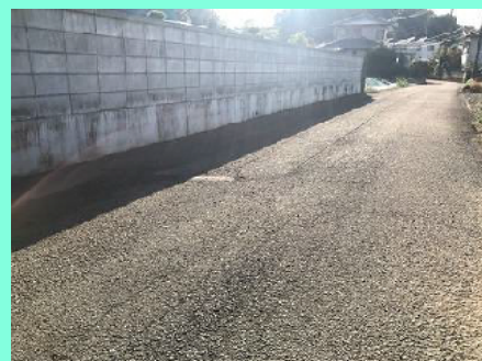
市道の修繕（堀之内）
