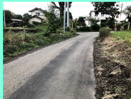
市道の修繕（糎谷）
