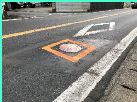
消火栓の修繕（糞谷）
