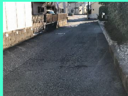
市道の修繕（若狭4丁目）
