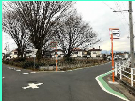
カーブミラーの設置（三ヶ島5丁目）
