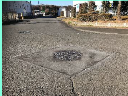
マンホールの修繕（林1丁目）
