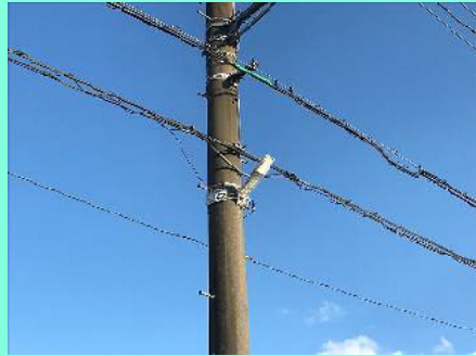
道路照明灯の設置（梶谷）
