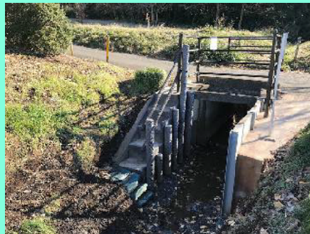
階段の修繕（樽井戸川上流）
