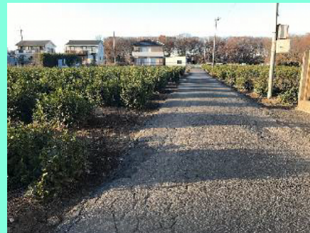
市道の修繕（林2丁目）
