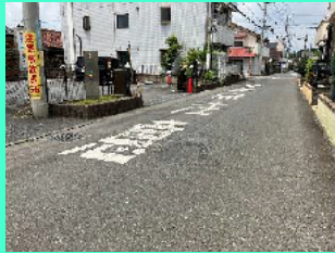
市道の修繕 (三ヶ島4丁目)
