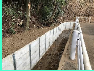
東川の護岸改修 (三ヶ島1丁目)
