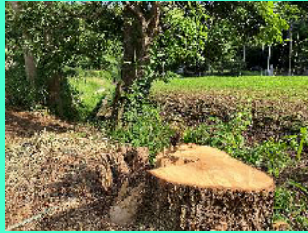
樽井戸川沿いの倒木の撤去 (糞谷)
