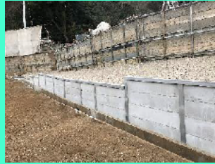
水路沿いの改修 (三ヶ島1丁目)
