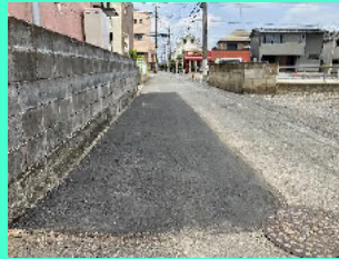
市道の修繕 (和ヶ原2丁目)
