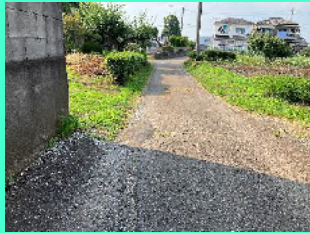
市道の修繕 (堀之内)
